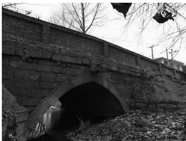
【写真1】「晋橋」（龍頭側）
