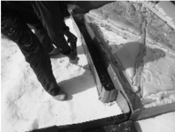
(11) 1液充填型のスプレー式発泡ウレタンフォームで型枠とのすき間を埋める。
