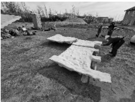
(21) 現場からの搬出準備
