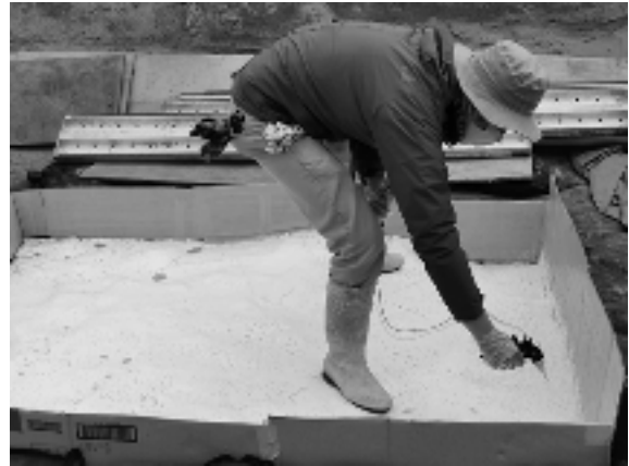
(10) 発泡ウレタン（インサルパック）の吹き付け
