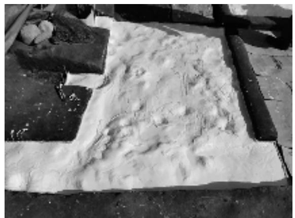
(8) 硬化したシリコンゴム層（樹脂の反応もよく、半日から一夜程度で硬化した。）
