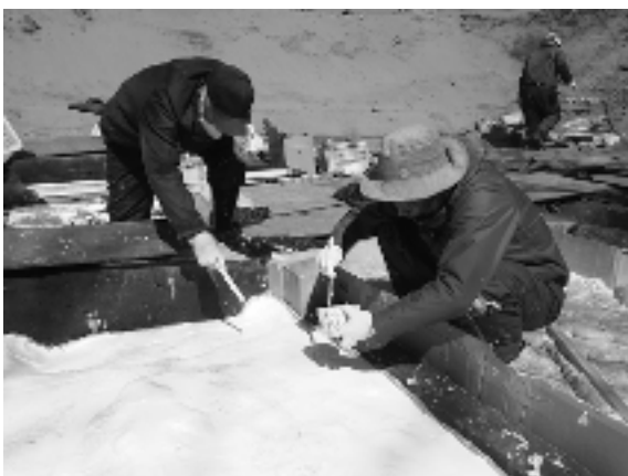
(7) シリコン樹脂2層目の塗布（半硬化して粘性が高まった頃合いに、2層目の強化部分に塗りつけるように塗布した。）
