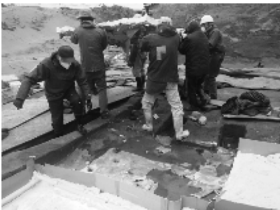
(15) 垂直に持ち上げて離型・取り上げ（数人の作業員で持ち運びが可能である。）
