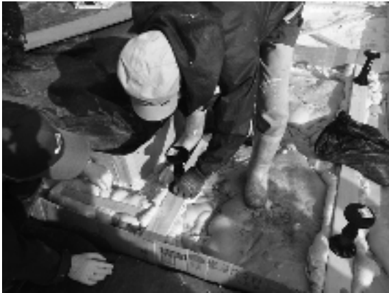
(13) アジャスター脚の取り付け（台木にホームセンターで購入した脚を取り付け。回転させて細かい上下の高さ調整が可能である。）
