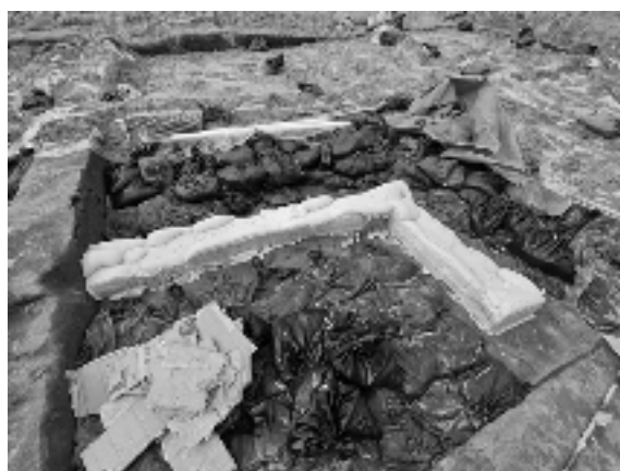
(24) 型枠に発泡ウレタン流し込み、硬化した状況 (周囲では現場の埋め戻し作業が進む)
