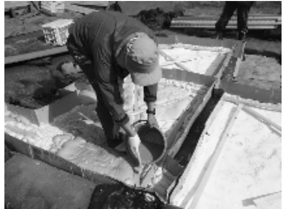
(12) 2液混合液体型発泡ウレタンの流し込み（バケツにT液・R液を同量混合し、発泡反応の開始と同時に流し込む。）
