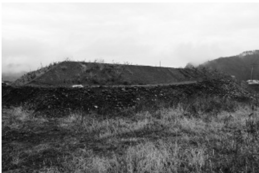
大槌町内の至る所で嵩上げのための盛り土工事が行われている。 (平成26年11月29日撮影)
