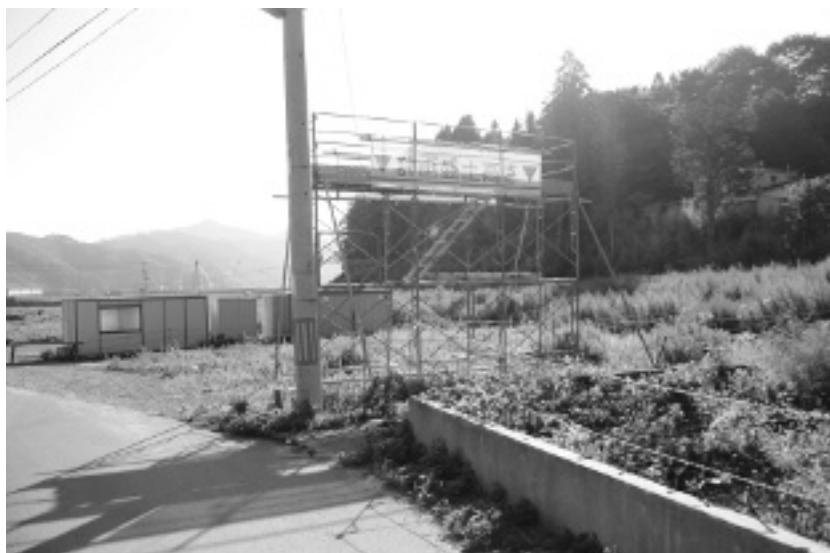
大槌稲荷神社境内下、大槌町公民館安渡分館前、計画盛り土表示 （平成26年8月3日撮影）
