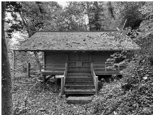
写真⑱ 2022年に完成した合氣神社の社殿
