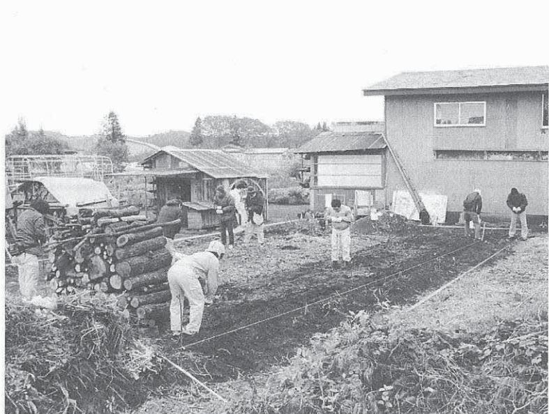
ボーリング探査
