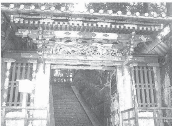
写真8 日光東照宮坂下門
