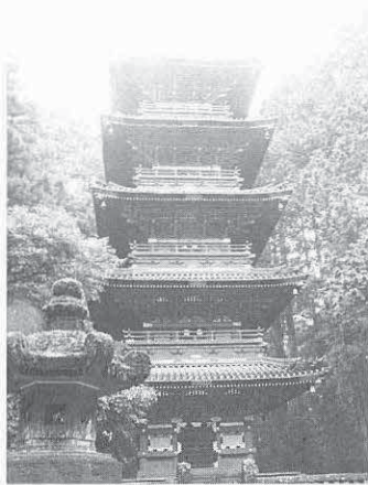
写真7 日光東照宮五重塔
