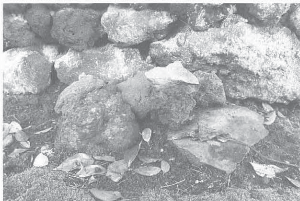
101. 不動堂 本堂真後ろの小石積
