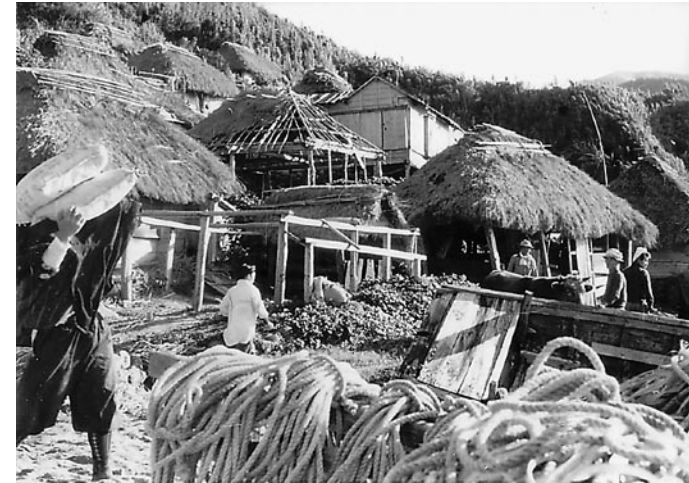
図13 建造中の西之浜集落 資料写真提供・南日本新聞社
