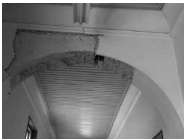
天井アーチ部
