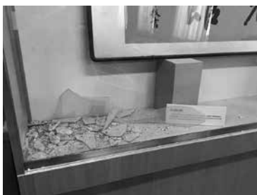
破損したケース部
