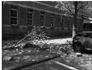
五高記念館裏側の崩落した煙突
